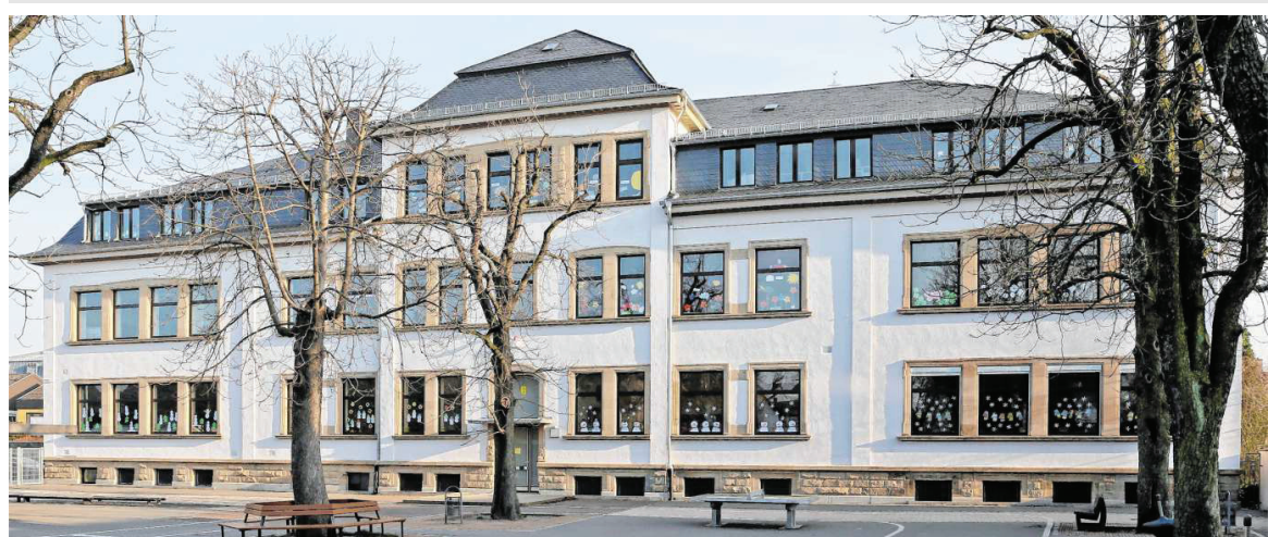
Altes Gebäude herausgeputzt: Nach der umfangreichen Außenanierung mit neuem Dach und frischem Anstrich geht's im Sommer im Inneren der Pestalozzischule mit der Beleuchtung weiter.
